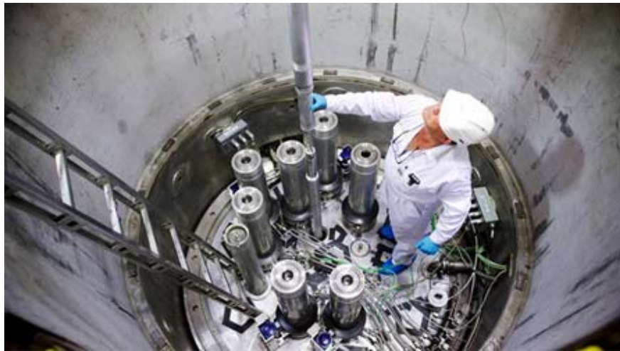
JEEP II 炉心上部照射キャプセルの設置
