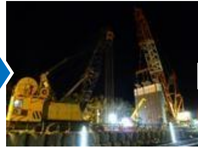
地中壁鉄筋建込 (24年1月撮影)
