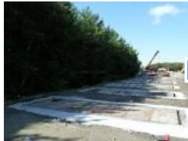
工事前 (23年10月撮影)
