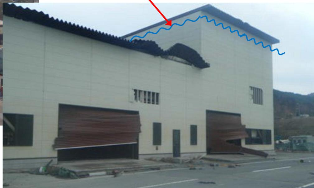
津波が天井付近まで押し寄せ、引いていったにも関わらず、壁の損傷は少ない。
