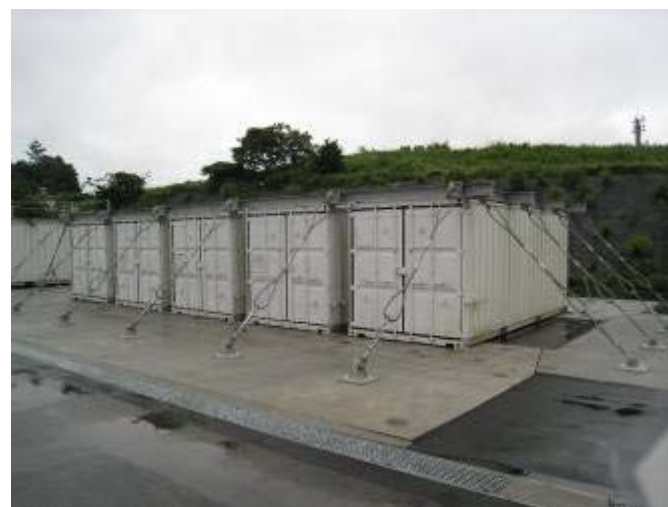
緊張固縛の例 (コンテナ)
