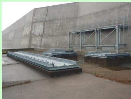
4号機取水路シャフト部
