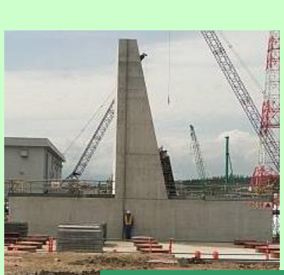
荒浜側防潮堤（杭基礎RC擁壁）
