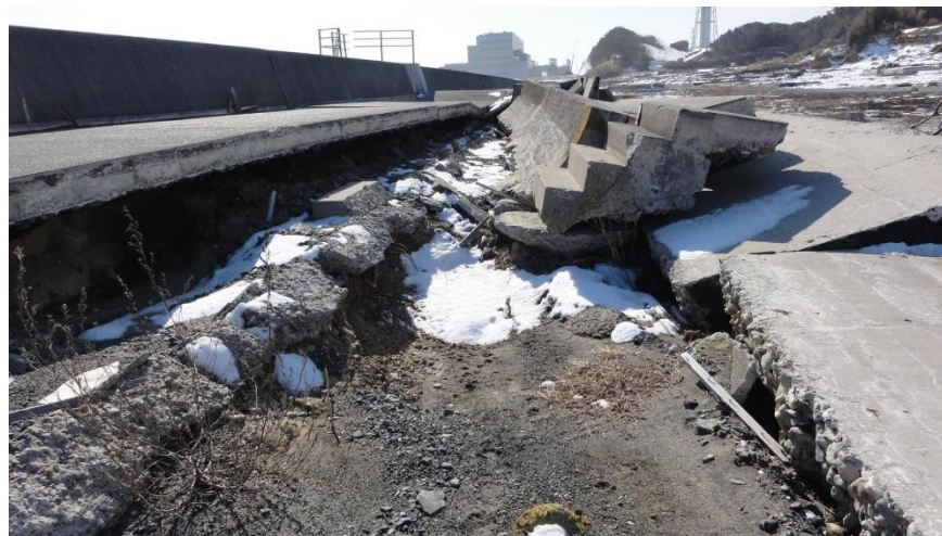
引き波によるスクリーンカバーの移動
