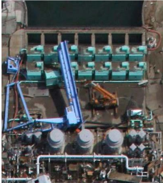
波力によるクレーンの転倒 ※転倒したクレーンによる 海水ポンプの損傷
