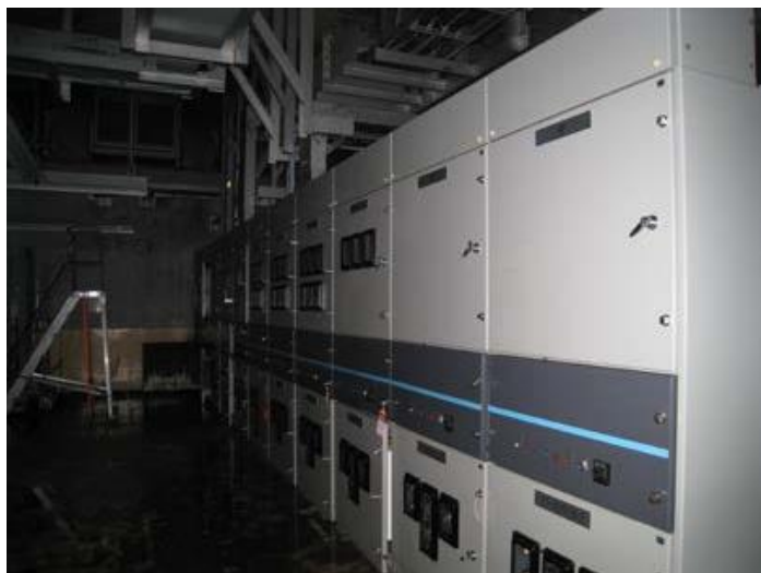
建屋内浸水による電気設備の機能喪失
