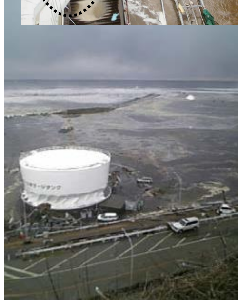
波力・静水圧によるタンク の座屈
