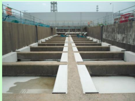
1号機補機取水路
