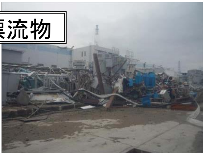
漂流物による建屋の損傷
