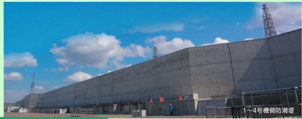
荒浜側防潮堤（杭基礎RC擁壁）
