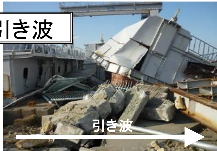
引き波によるスクリーンカバーの移動
