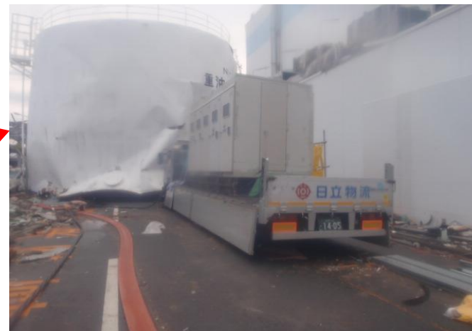
浮力と波力によるタンクの移動
