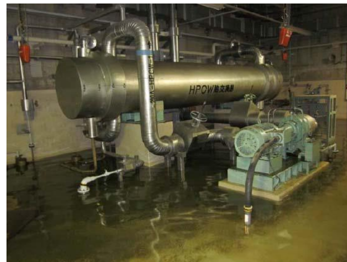
建屋内浸水による電気設備の機能喪失
