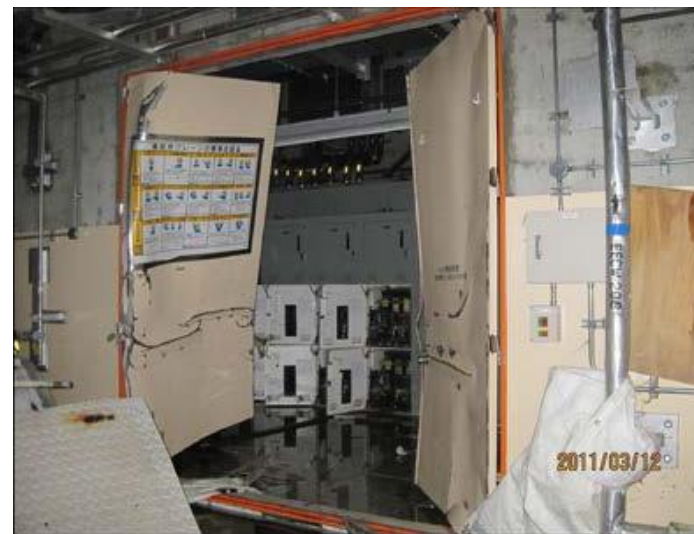
建屋内浸水による扉の損傷
