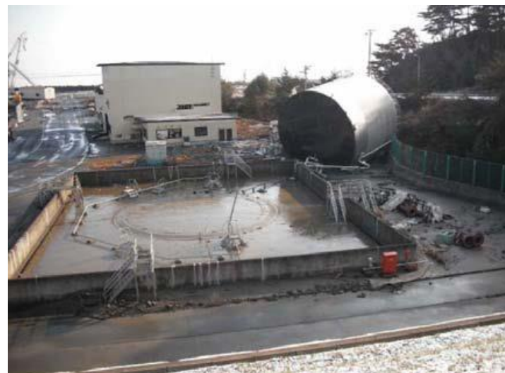
浮力と波力によるタンクの転倒
