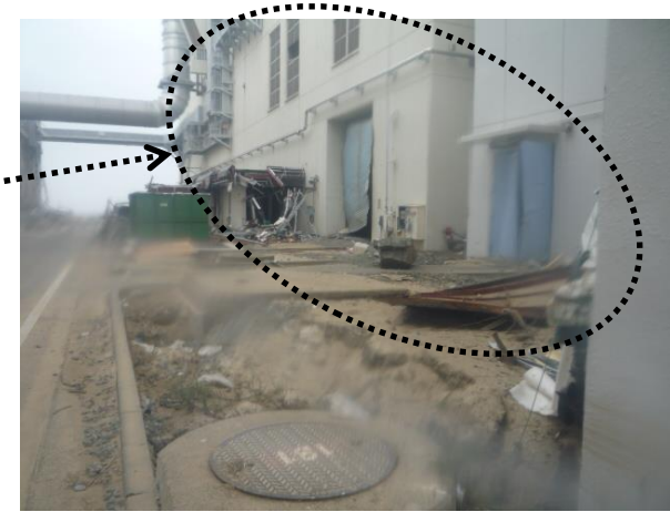
波力・静水圧による扉の損傷
