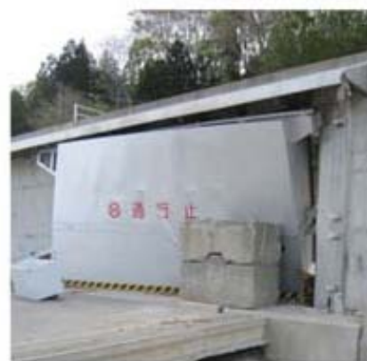
写真2 波力による防潮堤 防水扉の破壊(宮古)
