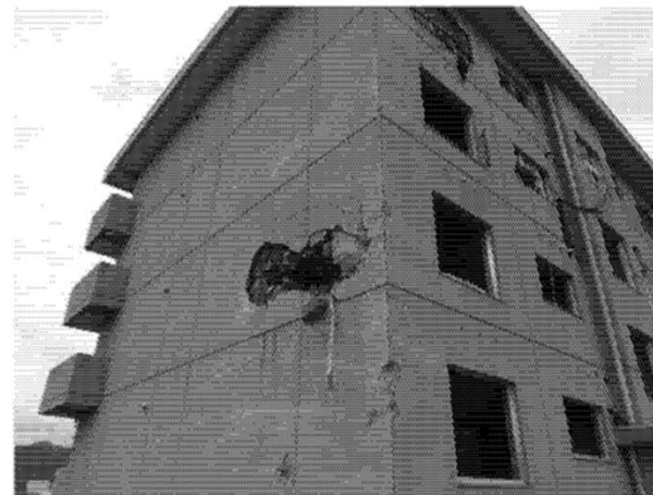
漂流物衝突による局部損傷
