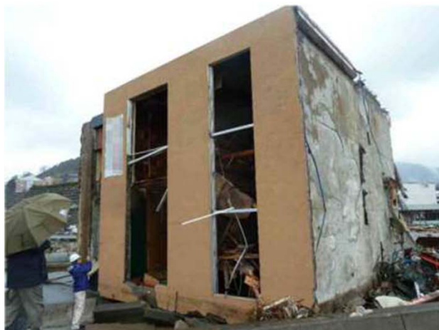
津波の波力による転倒
