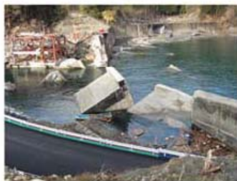
写真3 洗掘による防潮堤の 転倒(釜石市・両石)
