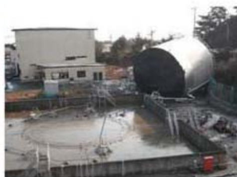
写真4 浮力による重油タン クの浮上・移動(東北電 力)
