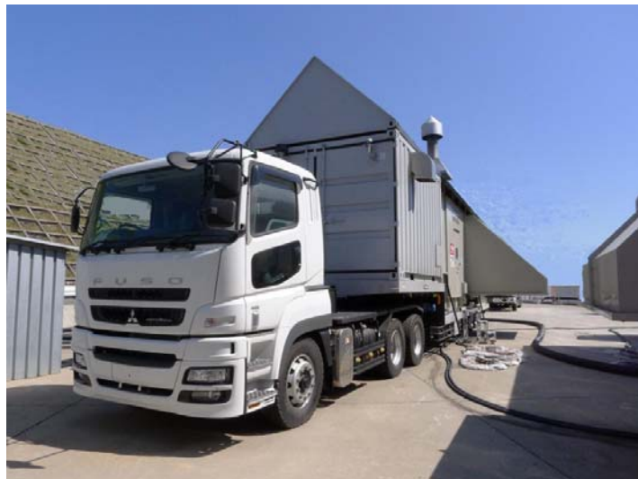
代替非常用発電機
