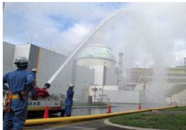
放水砲（訓練時）
