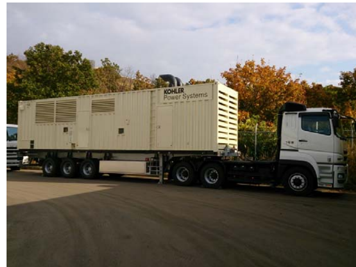
可搬型代替電源車
